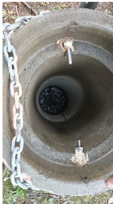
Vue du puits P-3 (16 septembre 2020)
