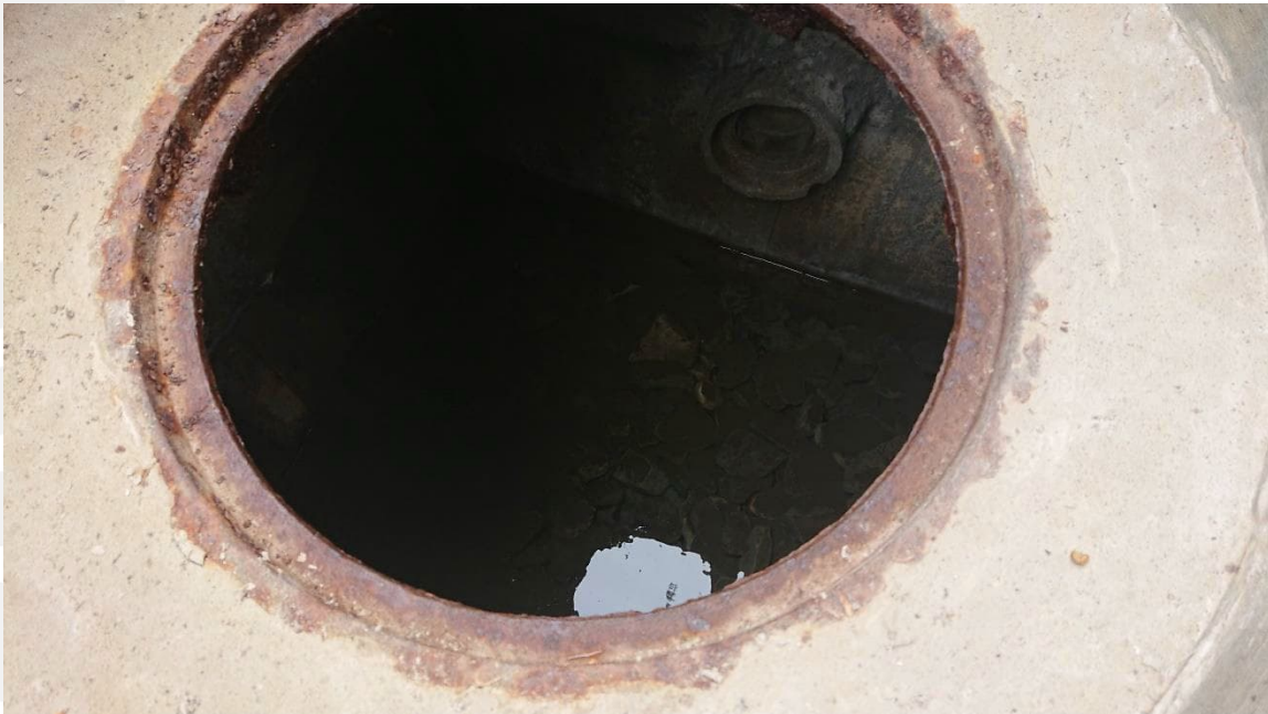
Vue du puits P-2 (16 septembre 2020)
